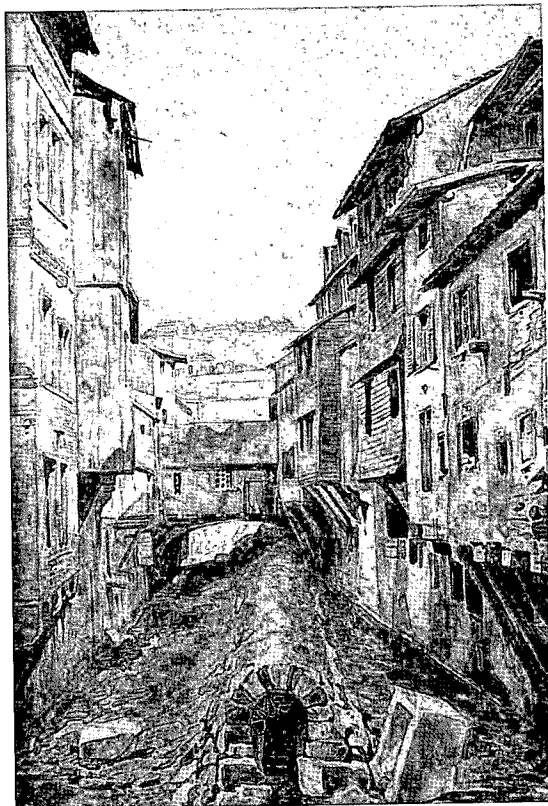
Fig. 60 Les autorités profitent de la tranchée laissée béante par le détournement du Seyon, pour installer la colonne vertébrale de leur système de canaux-égouts dans l'ancien lit de la rivière (2.4.3). Gouache, G. Grisel, vers 1844 (MAHN).
