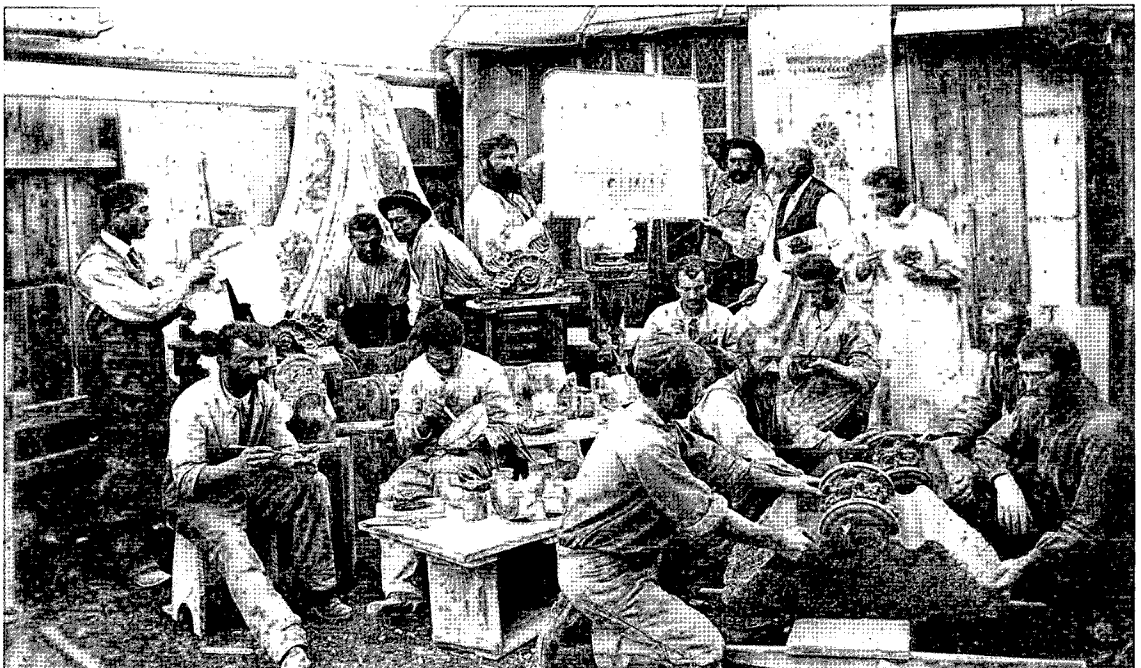
Fig. 15 A l'image des bâtisseurs de cathédrales, les ouvriers du chantier de l'Eglise rouge, 1897-1906 (2.6.2). Photographie anonyme (Paroisse catholique).
