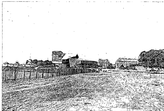
Fig. 6 – Vue du comblement de l'est de la ville en 1898: bains du Crêt, installation provisoire du spectacle du Cinquantenaire de la République et extrémité du jardin du Crêt (2.4.1). Photographie coll. Bickel (MAHN).
