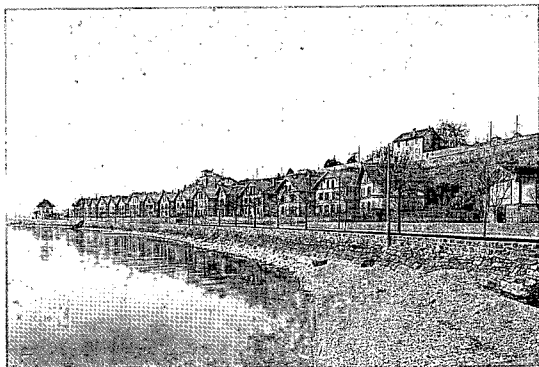
Fig. 50 Les abords de Serrières subissent également de profondes transformations: une route de rive et quelques lotissements comme la Cité Suchard remplacent les grèves (2.4.1). Photographie anonyme (Suchard).
