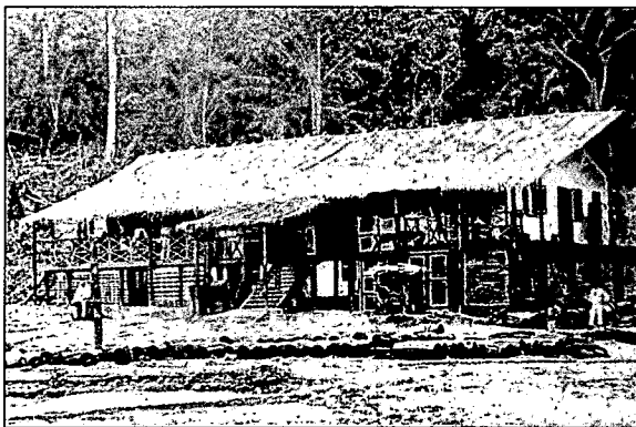
Une des cases construites par Nassau (Probablement à Talagouga ?)
