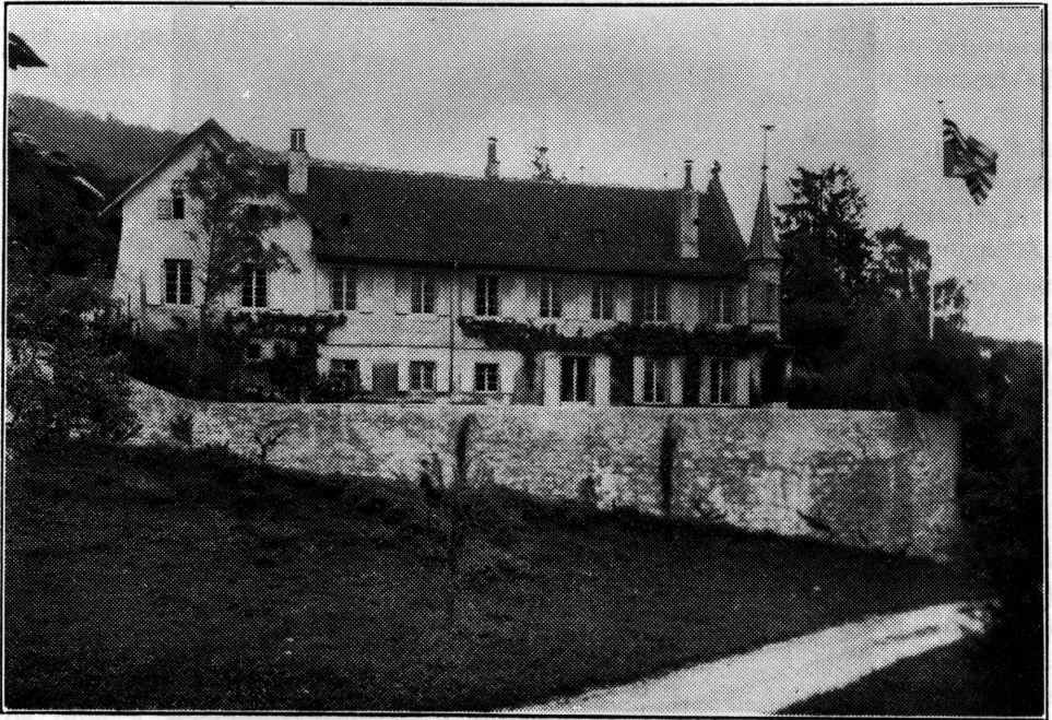
Abbaye de Fontaine-André, vue moderne, façade sud.
